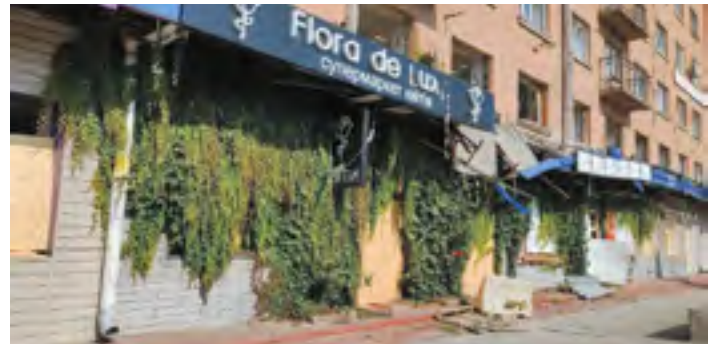
Рис. 4. Вертикальне озеленення, що на відміну від будівлі витримало ракетну атаку (м. Київ)
