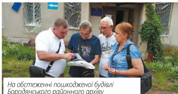
На обстеженні технічного стану пошкодженого багатоквартирного житлового будинку в Макарові
